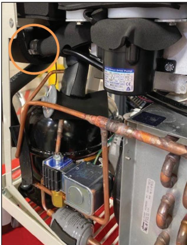
Fig. 8-22 Desligue dois grampos (Passo 3 - Bomba de CC)
