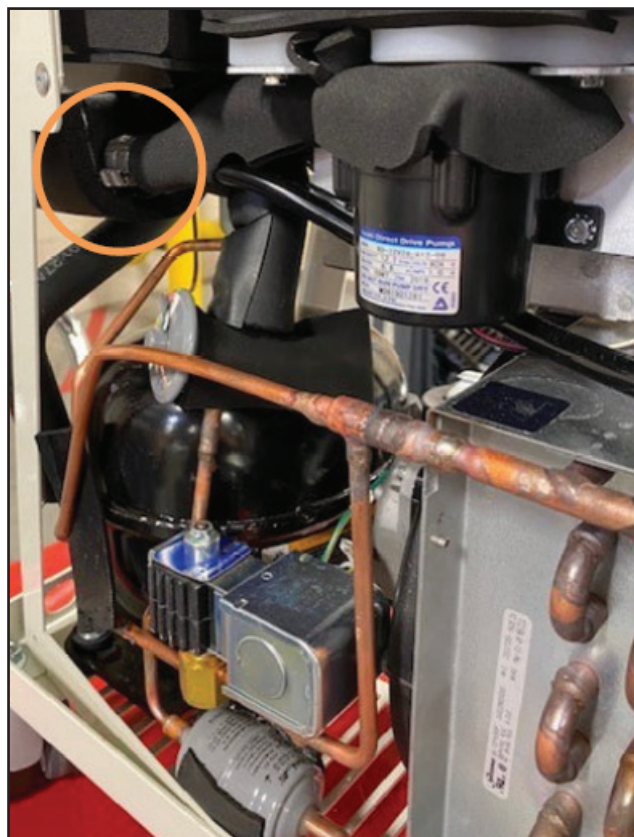
8-22. ábra Válassza le a két bilincset (3. lépés - Egyenáramú szivattyú)
